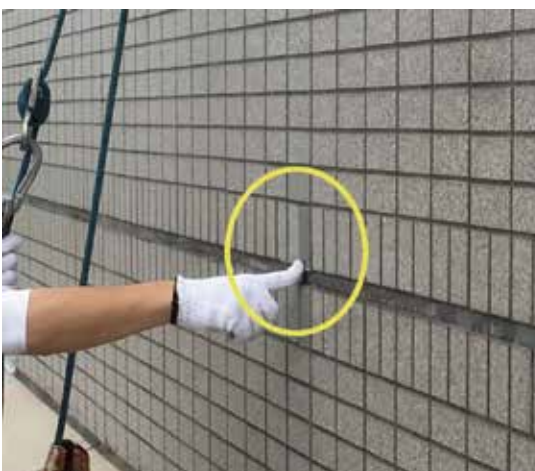
外壁タイルの浮きの確認
