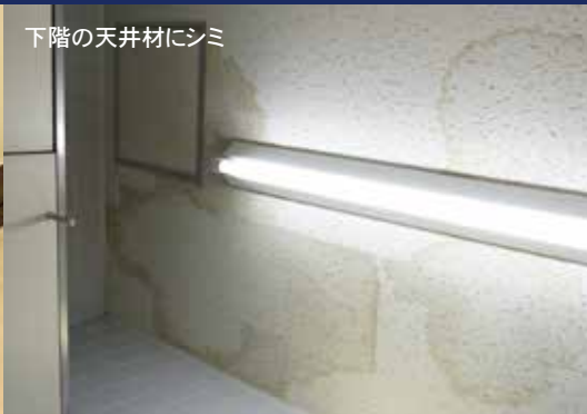
下階の天井材の剥離
